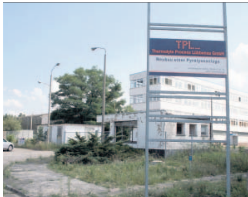
Zunächst in einer der beiden hinteren Hallen (links verdeckt) will die Thermolyte Prozess GmbH (TPL) eine Pyrolyseanlage errichten. Foto: H. Linke
